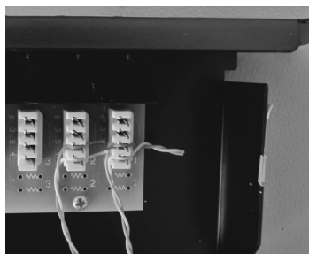
图 5-75 线芯压入打线槽
