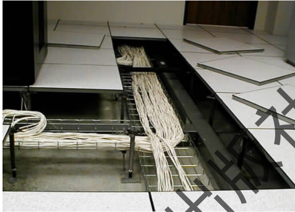
图 4-18 高架地板式布线
