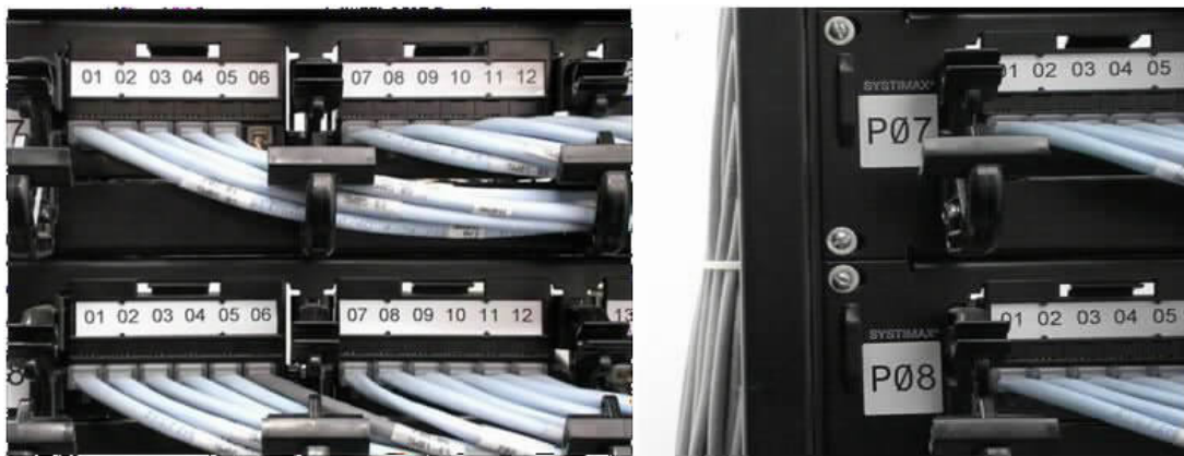
图 4-39 配线架端口标识
